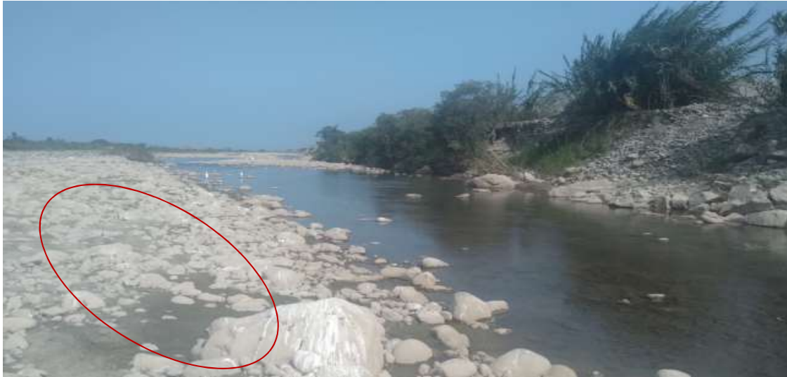
FIGURA N°01: , PROG. 4+000 - LA EXISTENCIA DE AREAS COLMATADAS POR ENCIMA DEL CAUCE Y EXISTENCIA DE DIQUES EROSIONADOS POR UNA AVENIDA.
