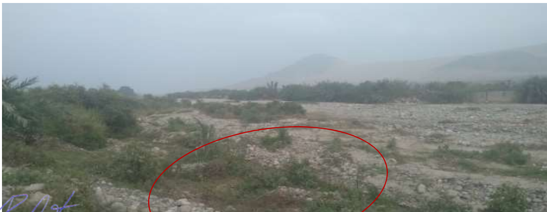
FIGURA N°02: , PROG. 4+400 - LA EXISTENCIA DE AREAS COLMATADAS POR ENCIMA DEL CAUCE Y ESTAN VULNERABLES AMBAS MARGENES DEL RÍO.
